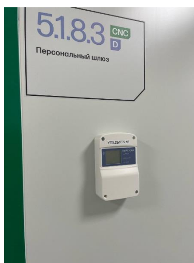
Рис. 5. Проводной узел «Пирс-CAN»: примеры скрытого монтажа при применении для чистых помещений
