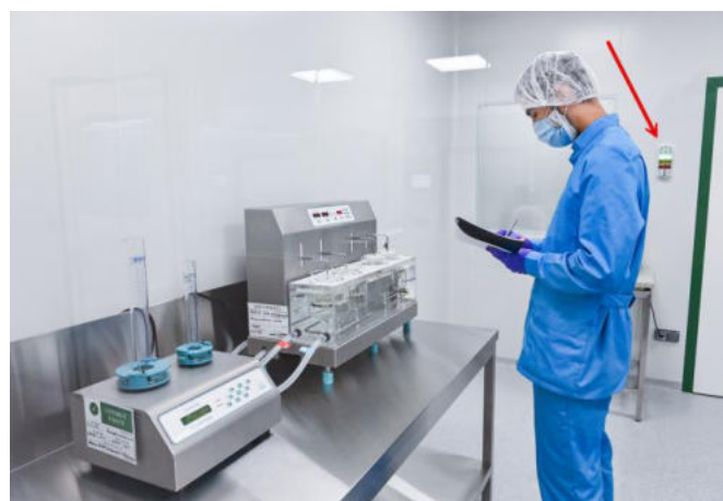
Рис.2 Установленная внутри чистого помещения трехцветная световая колонна
