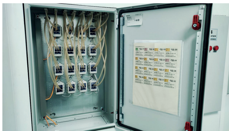
Рис. 4. Шкаф с датчиками перепада давления ИПМ-41-03-1
