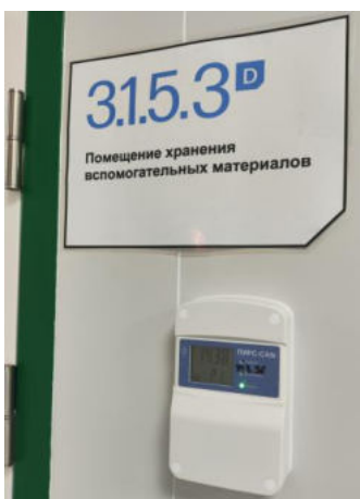
Рис.1 Узлы «ПИРС-CAN» с трехцветными светодиодными индикаторами
